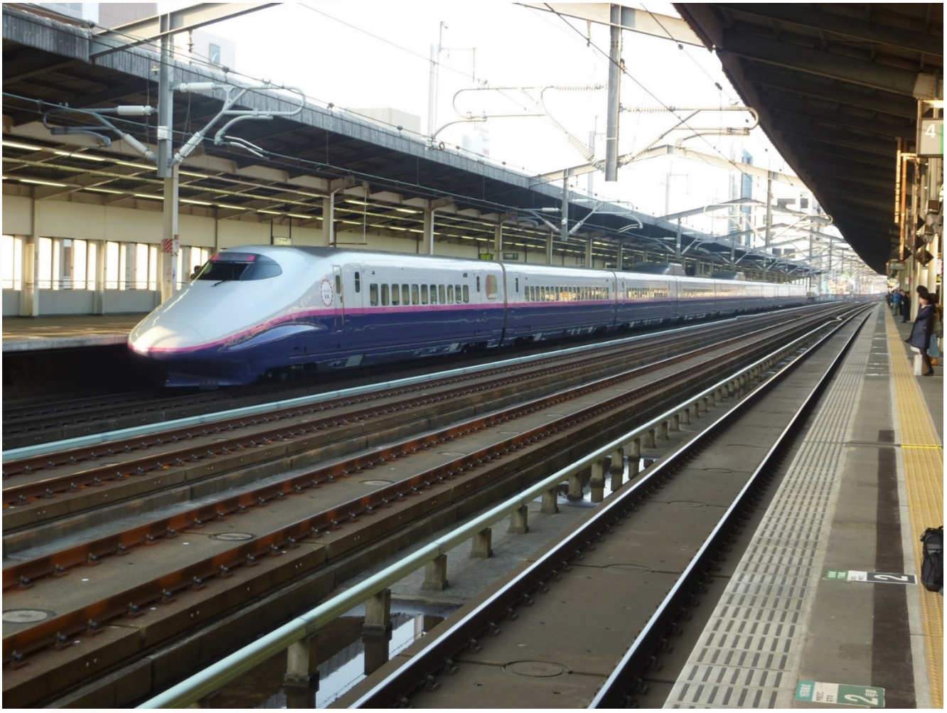
Estación de paso en el centro de la ciudad: Omiya
